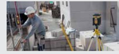
旋转激光水平仪、激光标线仪和
