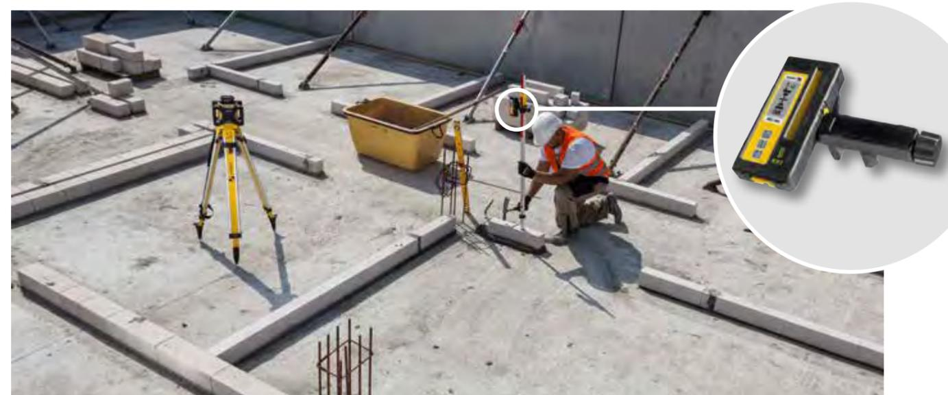
Большой рабочий диапазон в комплекте с ресивером REC 160 RG: до 600 м (диаметр). Ресивер с держателем имеет большой диапазон приема по высоте (80 мм) и идеально подходит для работы на больших расстояниях. С визуальным сопровождением (измерения) цели с акустическим сигналом, а также дисплеями на передней и задней панелях. Освещение включается нажатием кнопки.
