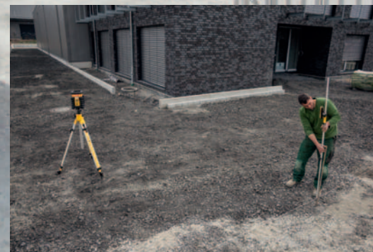
Ejemplo de aplicación: Nivelación de una superficie de empedrado con una inclinación de hasta 5°.
