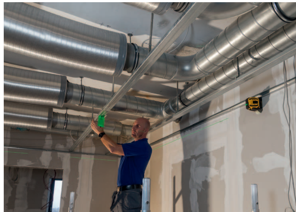
Plaquistes – Suspension de plafonds, pose de parois et de cloisons de séparation, montage de profilés U et implantations du sol au plafond.
