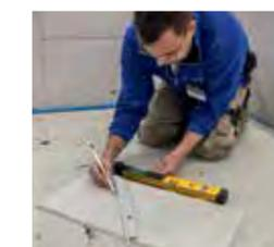
**TECH 700 DA:** particolarmente indicato per lavori di carpenteria in legno e falegnameria – misurazione e trasferimento di angoli, ad esempio nell'installazione di cucine o per l'allineamento di altri mobili da incasso. L'assistente ideale durante la posa di piastrelle con motivi complessi – trasferimento degli angoli durante il taglio delle piastrelle. Il partner
